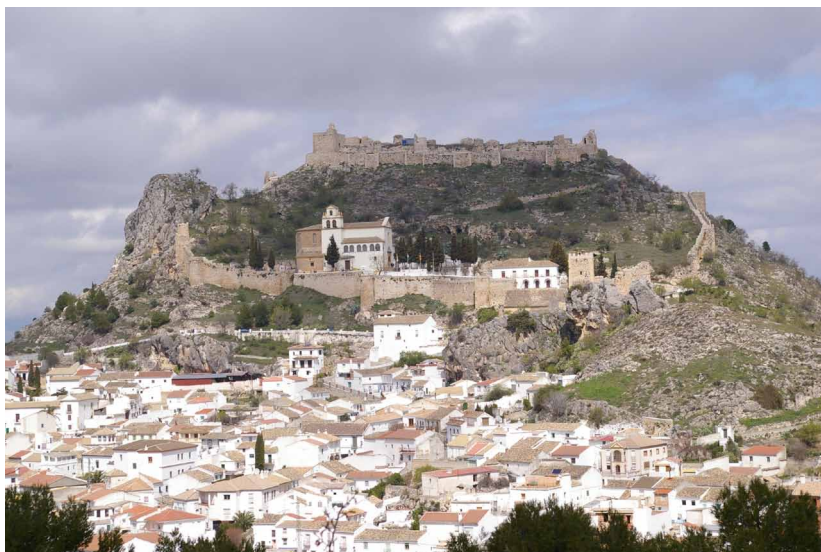
Lámina 1. Vista general de la localidad de Moclín.
