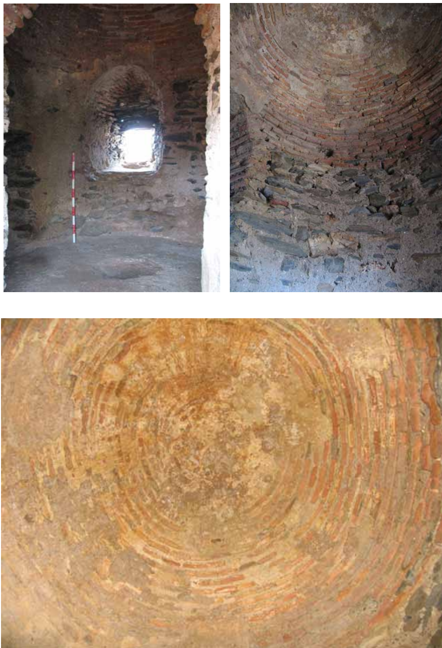
Lám. 12. Detalles del interior de la estancia, aparejo y relación con la bóveda (Foto Gespad al-Andalus S.L.U. 2010).
