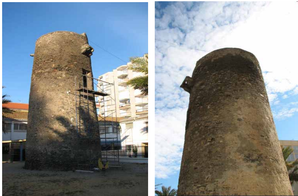
Lám. 10. Vistas del exterior de la torre vigía previas al inicio de los trabajos arqueológicos (Foto Gespad al-Andalus S.L.U. 2010).
