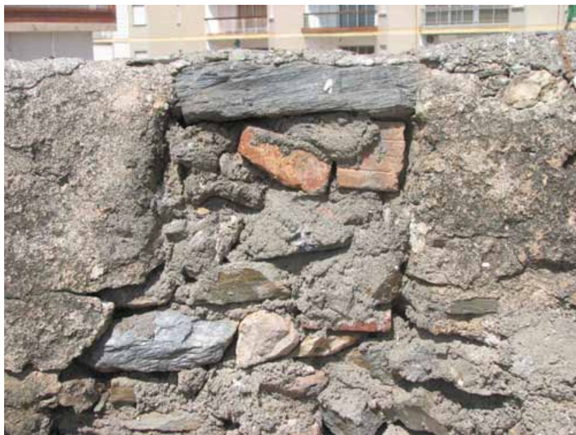
Lám. 22. Detalles de cada una de las troneras, actualmente cegadas, salvo la que cae sobre la salida de la escalera (Foto Gespad al-Andalus S.L.U. 2010).
