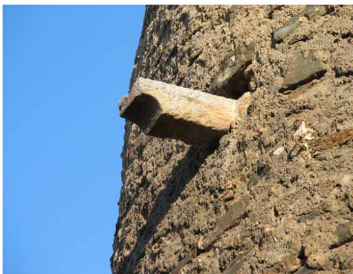
Lám. 18. Detalle de la chimenea y de la gárgola de desagüe (Foto Gespad al-Andalus S.L.U. 2010).
