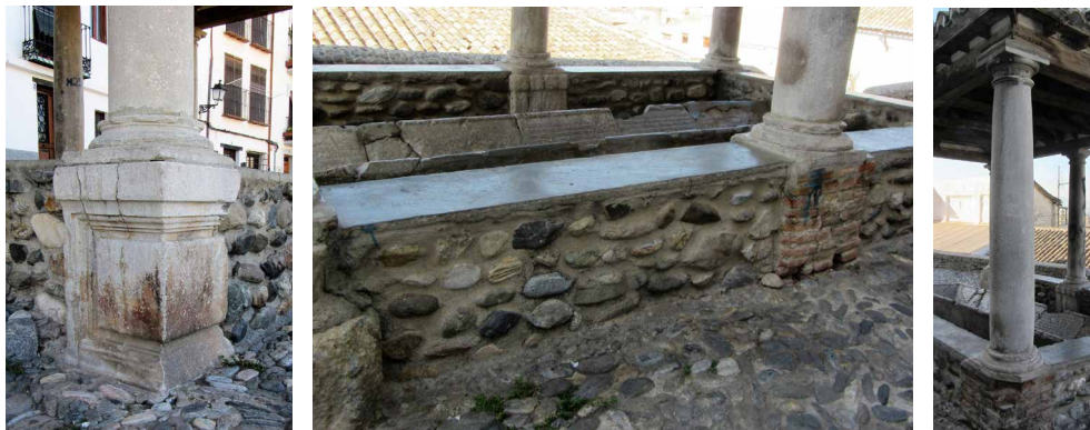
Láminas 15, 16 y 17. Detalles de las columnas, pretilas y pedestales del lavadero público de la placeta de la Puerta del Sol en la actualidad. Enero de 2018. Fotos: Daniel Quesada Morales.
