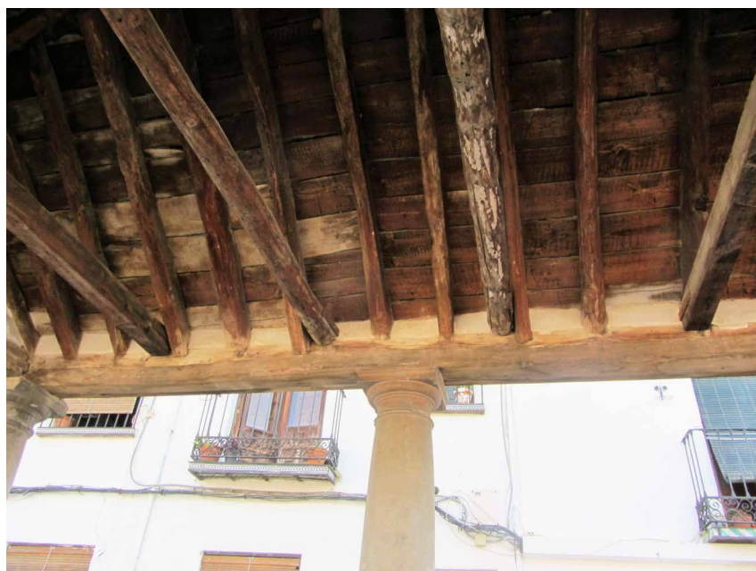
Láminas 12, 13, y 14. Detalles de la pila y de la techumbre del lavadero público de la placeta de la Puerta del Sol en la actualidad. Enero de 2018. Fotos: Daniel Quesada Morales.
