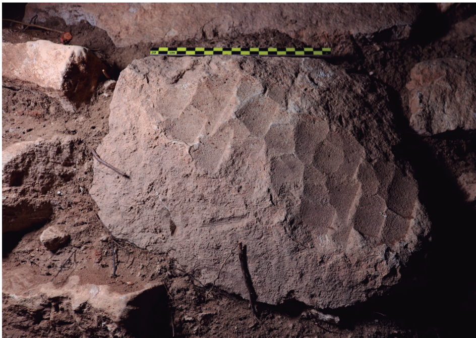
Lámina 10. Mampuesto con restos de cinceladas en el paramento de la muralla de la zona 5 (autores).
