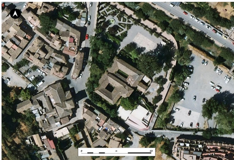
Lámina 5. Ortofoto de la Casa-Molino y su entorno. El edificio está compuesto por una zona productiva (noreste) y una zona residencial (suroeste). Elaboración propia.
