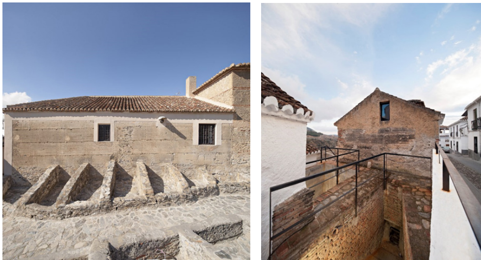
Lámina 4. Exteriores de la sala de prensado en tapial y trojes. Estudio Chico Muñoz Arquitectura.
