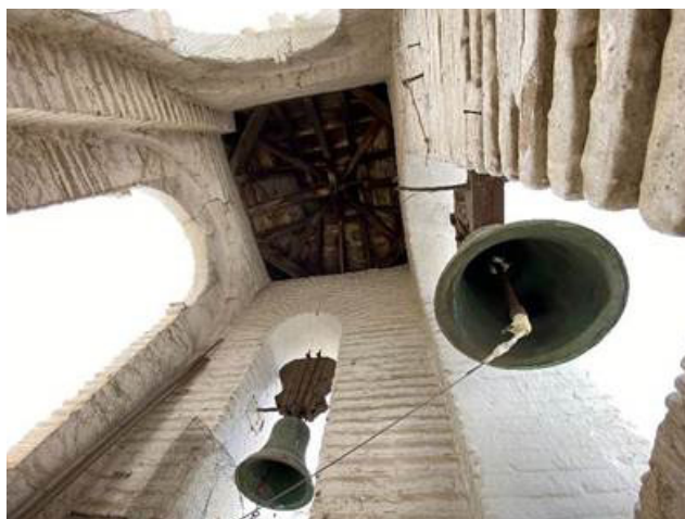
Lámina 19. Interior del campanario. Autoría propia (2022).
