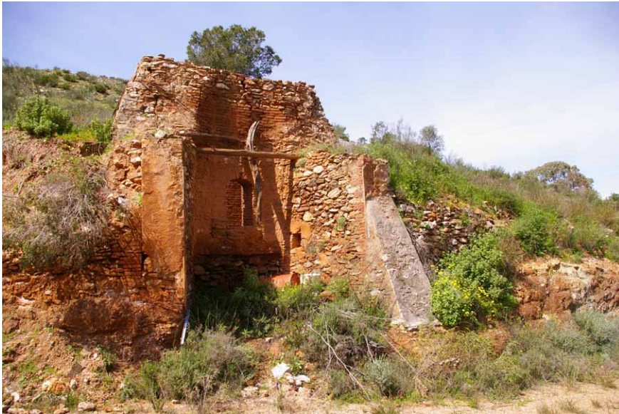
Lámina 4. Restos de las explotaciones mineras de la Sierra de Lújar
