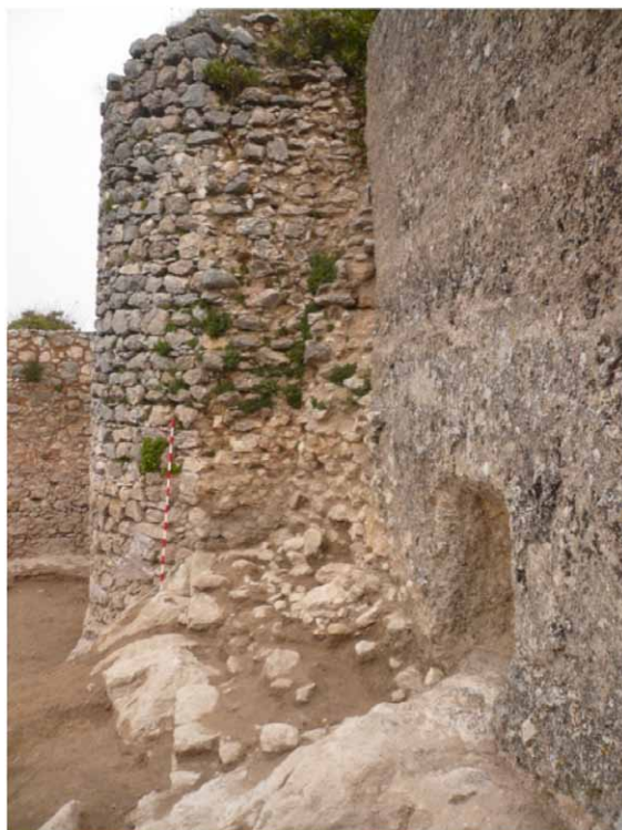
Lámina 19. Restos del tramo de muralla descubierto entre la Torre L y la A
