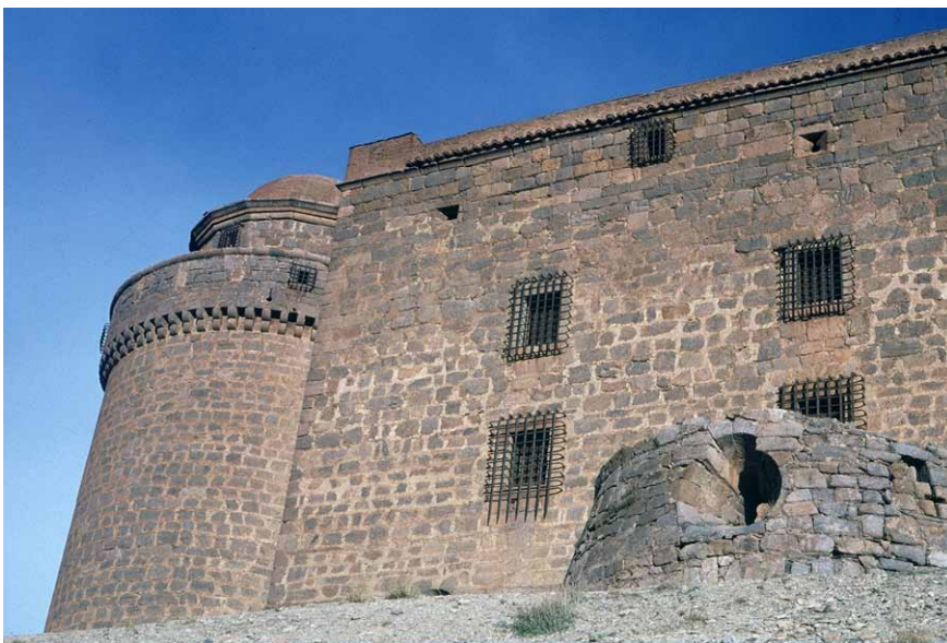
Lámina. 11. Paramento del cuerpo oeste. Pueden apreciarse los dispositivos defensivos que lo hacen incoherente con el resto de la muralla (J. M. Gómez-Moreno Calera)
