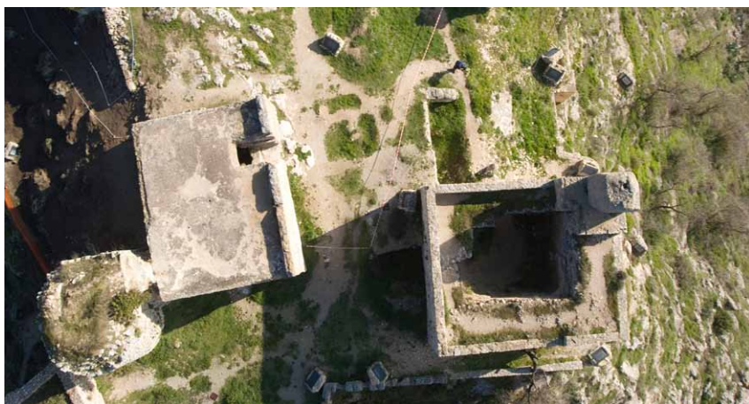
Lámina 26. La torre A o del Homenaje. La fábrica interior es de tapial calicestrado
