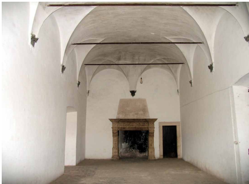
Lámina 15. Salón de Occidente con bóveda de medio cañón y lunetos, sostenidos con ménsulas de piedra talladas en Italia (J. M. Gómez-Moreno Calera)
