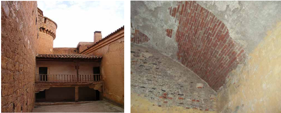
Láminas 13 y 14. Patio conocido como de las Damas o de la Servidumbre y detalle de la bóveda de ladrillos sobre la que se monta
