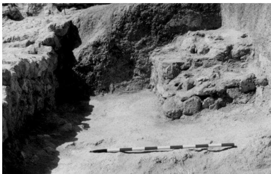
Lámina 7. Escaleras de acceso desde la parte inferior del patio a la superior en la vivienda construida junto a la Torre Puerta
