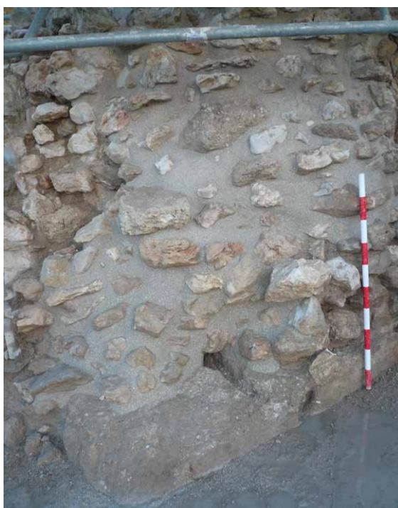
Lámina 15. Bloques de tapial hormigonado hallados bajo la torre C1. Restos del primer castillo de Moclin
