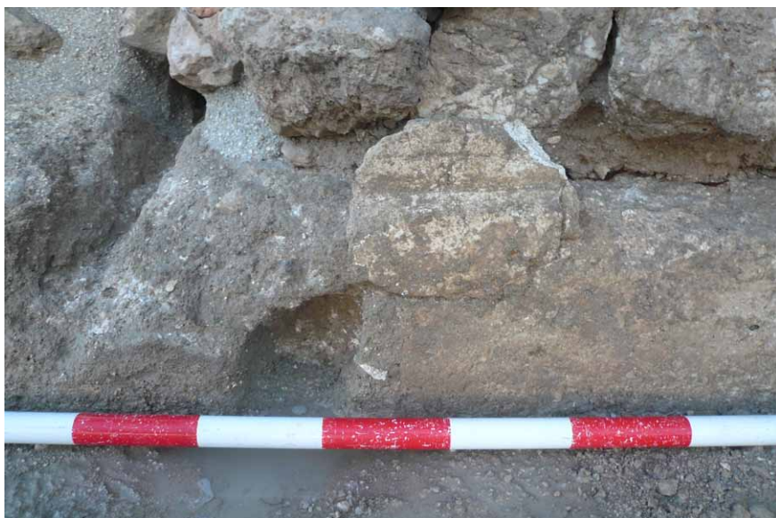
Lámina 16. Detalle de los bloques de tapial hormigonado bajo la torre C1
