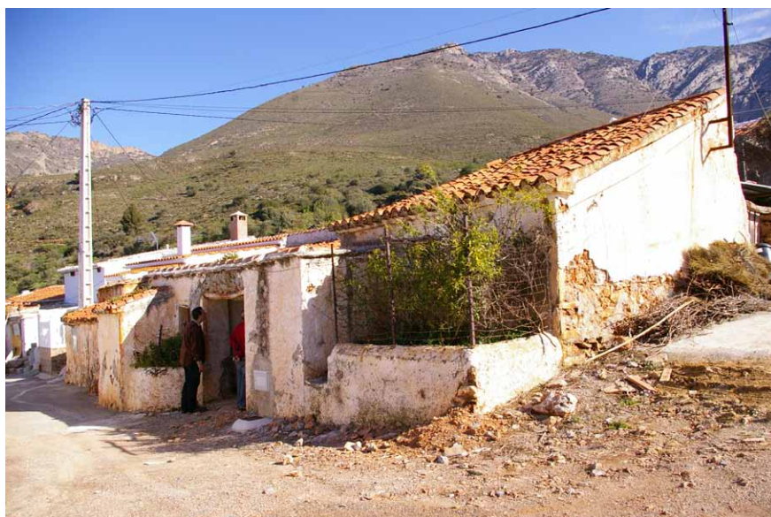
Lámina 8. Arquitectura tradicional. Lagos
