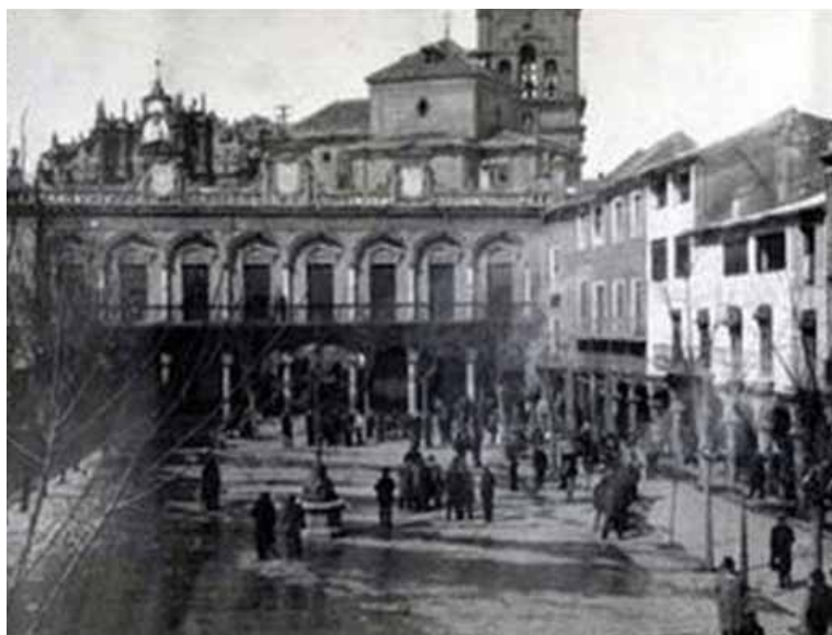
Lámina 2. Primitivo edificio del Ayuntamiento de Guadix, antes de la Guerra Civil. Foto cedida por Torcuato Fandila
