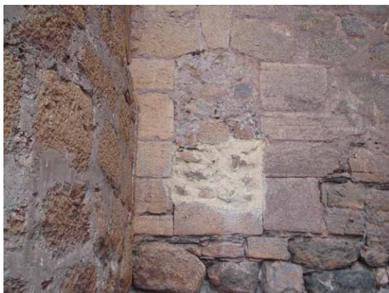
Lámina 10. Poterna del castillo de La Calahorra y recreación de la misma, en la que tras el tapiado se puede rastrear el blindaje original según Luis de Mora Figueroa
