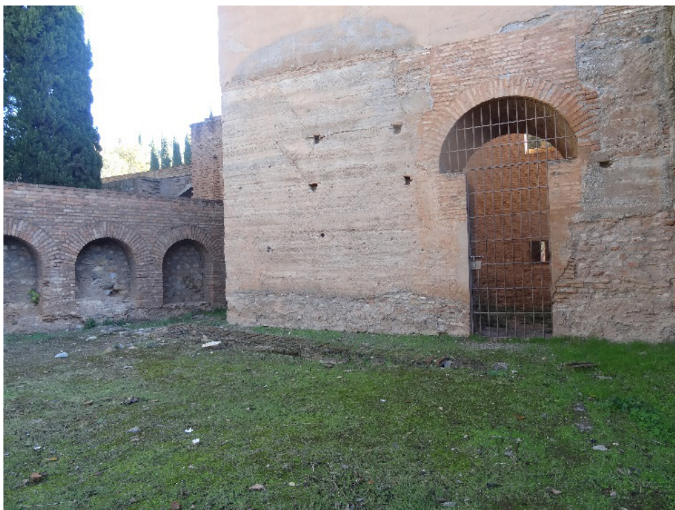
Fig. 11. Acueducto interior y alberca-partidor y atarjea que surten la Torre del Agua y las torres meridionales (Foto C. Vílchez)
