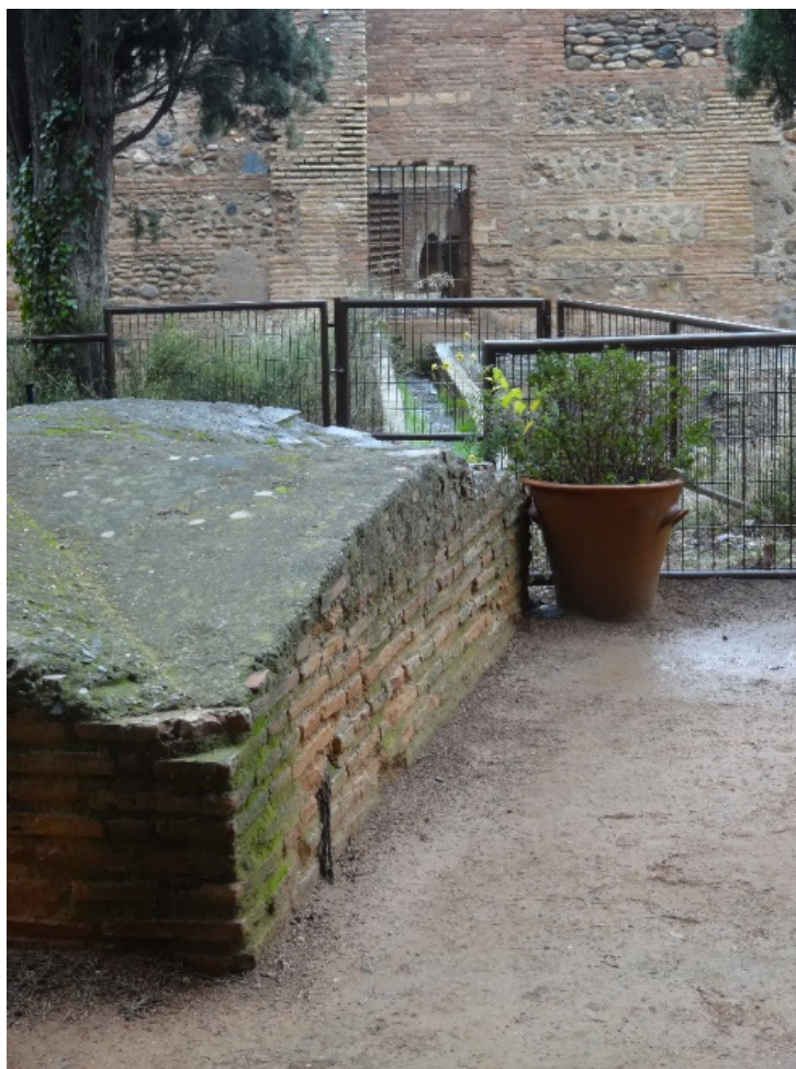
Fig. 4. Partidor de Fuentepeña y acueducto (Foto C. Vílchez)
