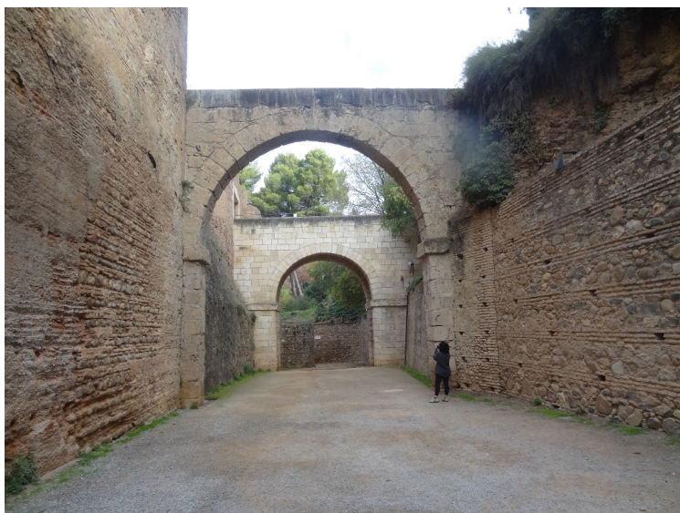
Fig. 2. Acueducto de la Alhambra en su cara Sur (Foto C. Vilchez)
