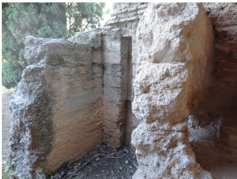
Fig. 5. Elemento hidráulico de tapial de hormigón dentro de la Alhambra. (Foto C. Vilchez)
