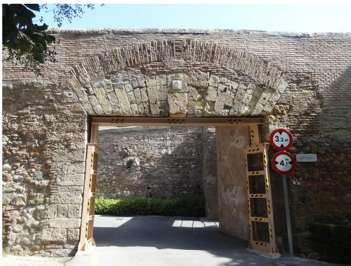
Lámina 27. Puerta de los Carros reforzada con estructuras metálicas en sus jambas y dintel por un accidente en 2018. (C. Vílchez. 2018).
