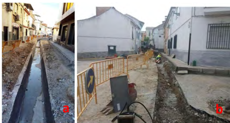
Lámina 9. a) trazado de la acequia principal proveniente del río Dilar hacia Gabia la Grande a su paso por el casco urbano de Alhendín, durante las obras de remodelación de la calle Vereda de la Acequia.
