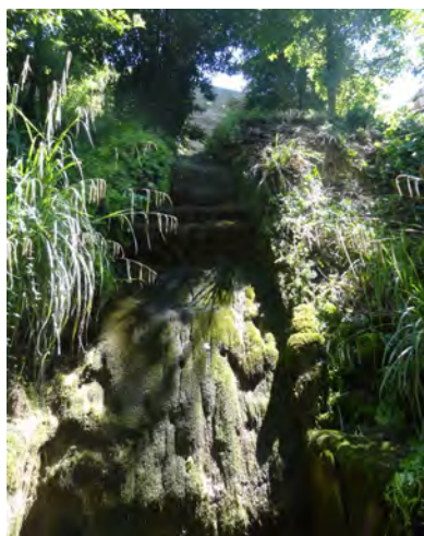
Lámina 10. «Caedero de agua» con los sobrantes del palacio de los Abencerrajes, junto al arranque del carril extramuros. (C. Vilchez, 2019).
